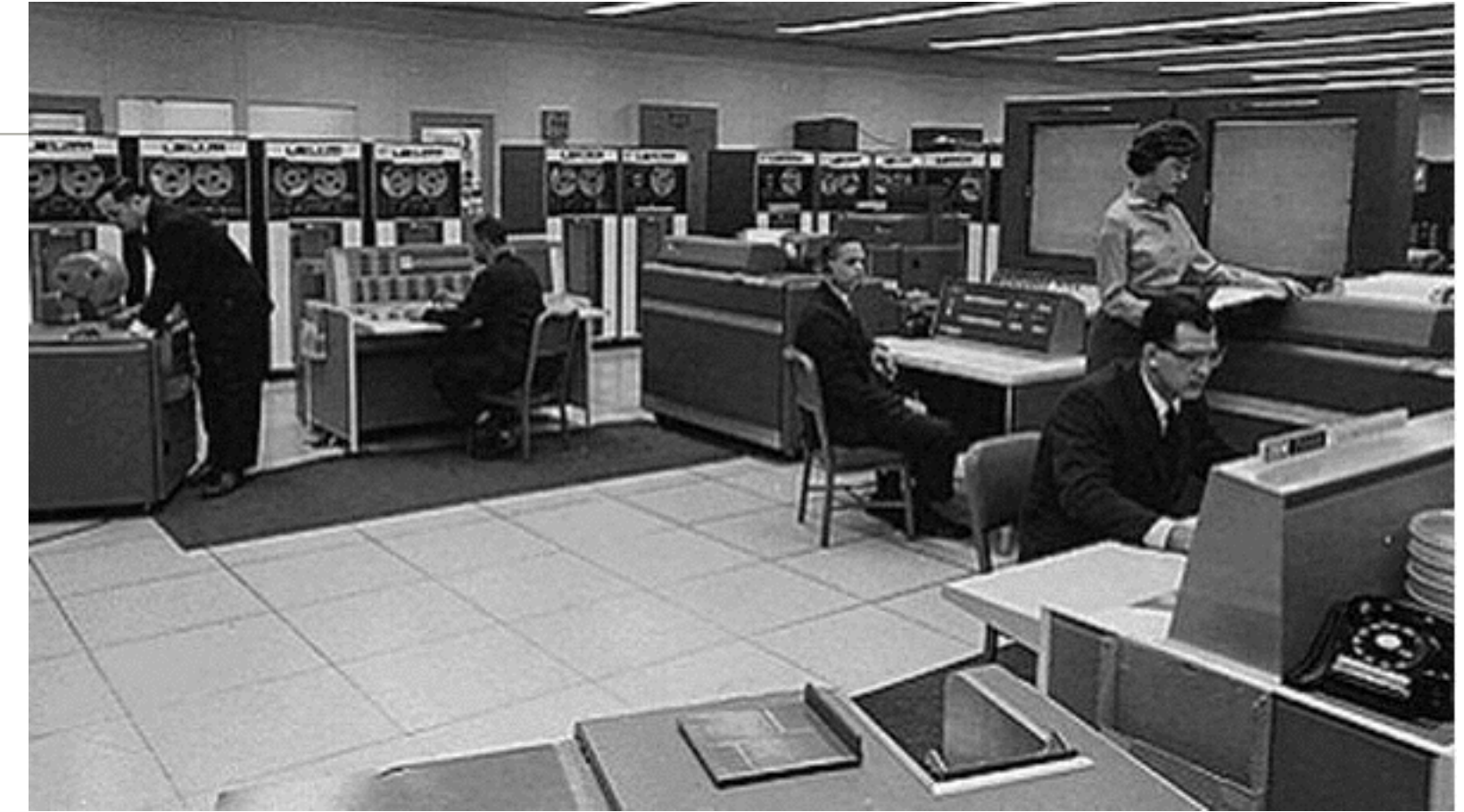
IBM 7090开始采用晶体管代替真空管。它是IBM第一台商用科学计算机，也是第一款批量制造的大型计算机。
