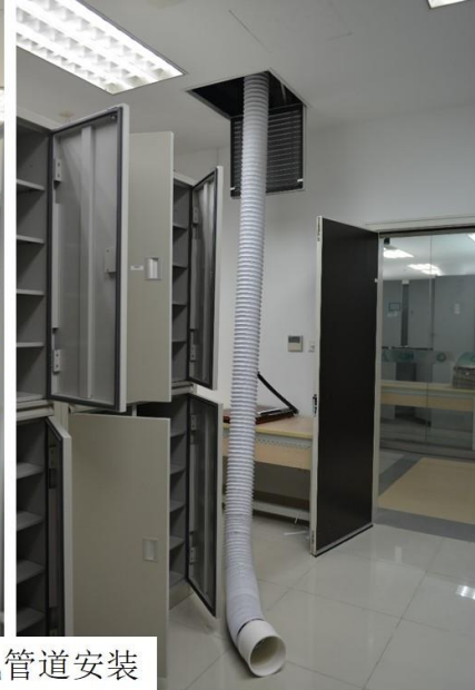
室内排风管道安装
